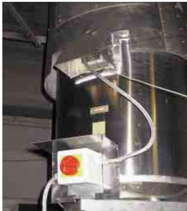
Wärmegeschützter Reparaturschalter, Kühlluftansaugstutzen
